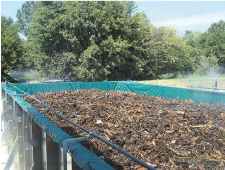
Fig. 2 Materiale filtrante contenuto nel biofiltro Ecochimica
