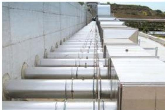
Fig. 4 Particolare del sistema di aereazione nel biofiltro Ecochimica
