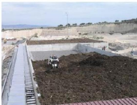
Fig. 10 Posa del letto filtrante su ghiaia e biomoduli carrabili
