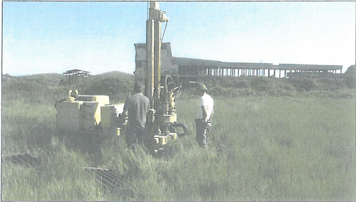
Foto nr. 5-6 Particolare di esecuzione del sondaggio geognostico numero 3 e relativa cassetta catalogatrice
