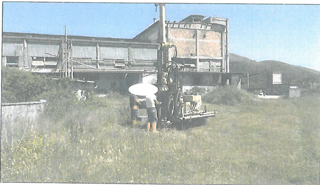
Foto nr. i 1-2 Particolare di esecuzione del sondaggio geognostico numero 1 e relativa cassetta catalogatrice
