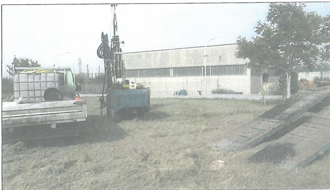
Foto nr. 13 Particolare di esecuzione del sondaggio geognostico numero 7
