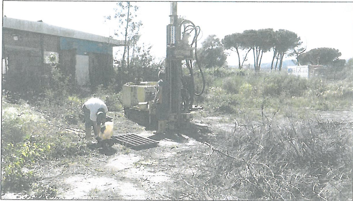
Foto nr.i 3-4 Particolare di esecuzione del sondaggio geognostico numero 2 e relativa cassetta catalogatrice
