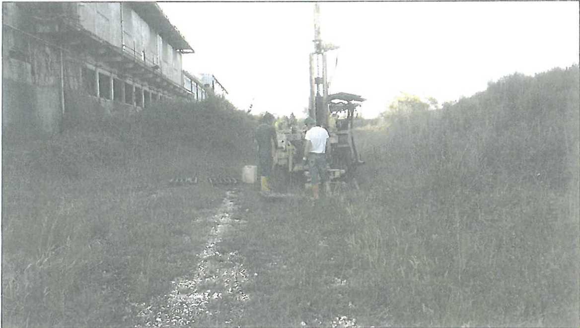
Foto nr. 9-10 Particolare di esecuzione del sondaggio geognostico numero 5 e relativa cassetta catalogatrice
