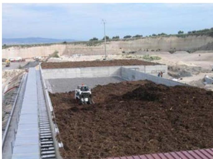
Fig. 10 Posa del letto filtrante su ghiaia e biomoduli carrabili.
