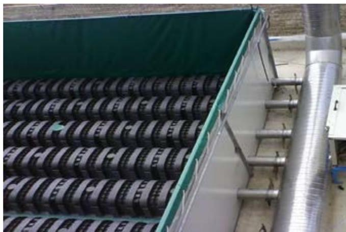
Fig. 3 Particolare del sistema di aereazione nel biofiltro Ecochimica.
