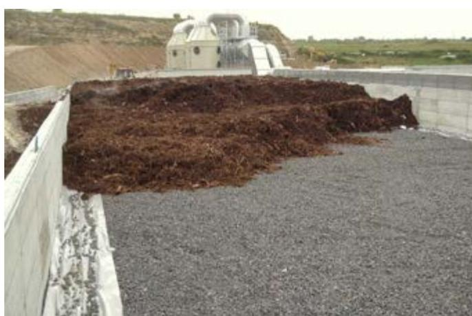
Fig. 9 Posa del letto filtrante su supporto di ghiaia.
