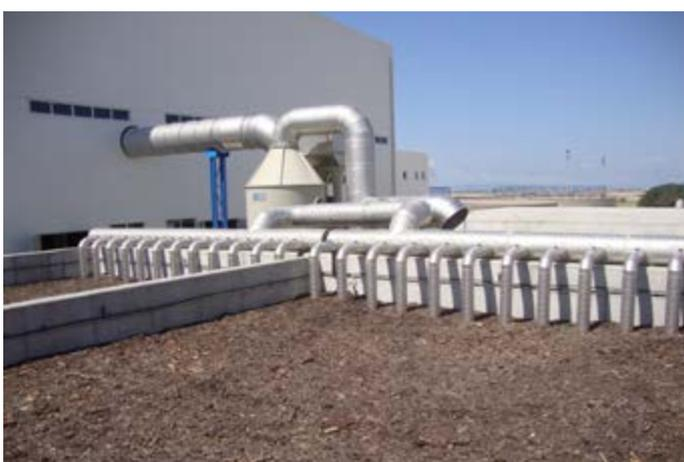
Fig. 5 Particolare del sistema di aereazione nel biofiltro Ecochimica.
