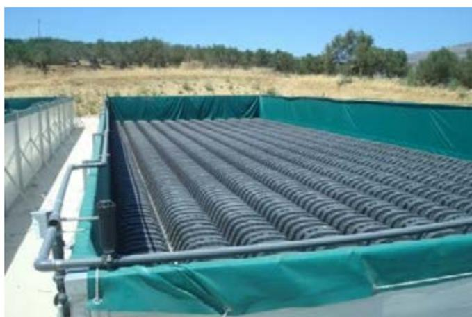
Fig. 7 Piano di supporto costituito da biomoduli carrabili, pronto per il riempimento con ghiaia.
