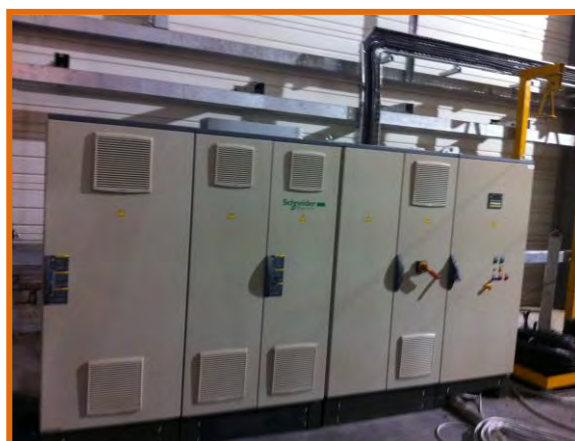
Figura 15 Armadio quadro elettrico
