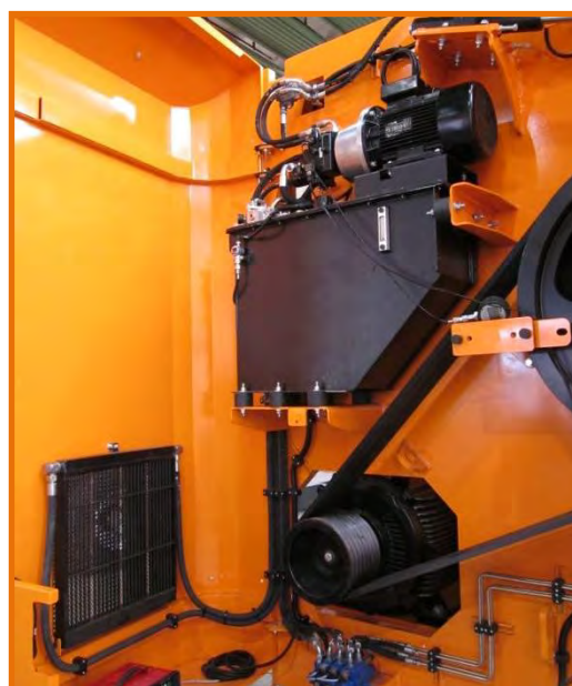
Figura 13 Particolare dell'impianto idraulico
