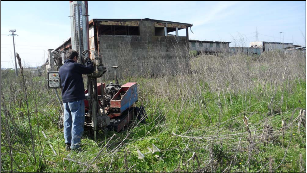
Foto nr. 7 postazione della prova penetrometrica cpt nr.1 – particolare fasi esecutive
