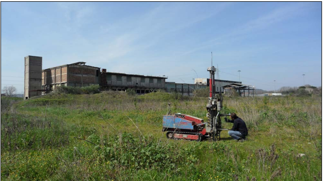
Foto nr. 6 postazione della prova penetrometrica nr. 8 – particolare del posizionamento
