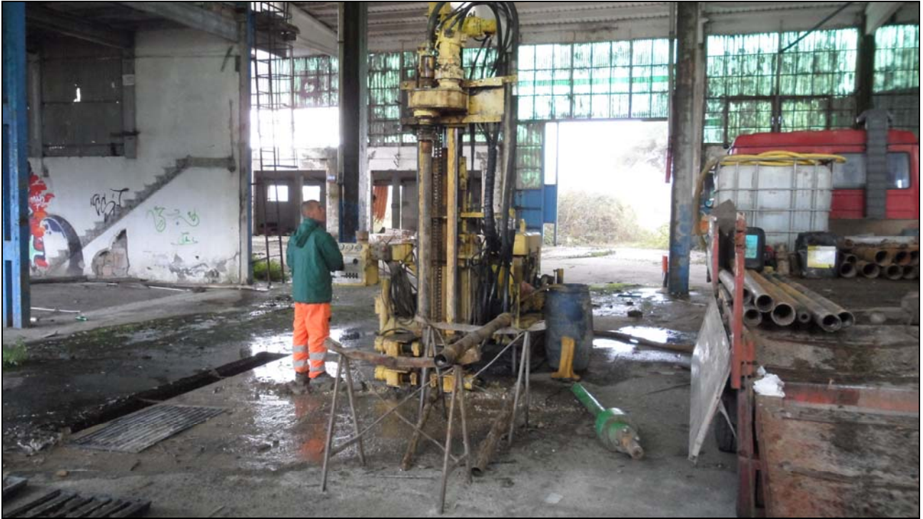
Foto nr. 9 postazione del sondaggio geognostico nr.1 – particolare fasi esecutive
