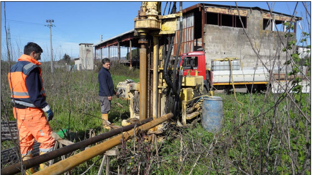
Foto nr. 10 postazione del sondaggio geognostico nr. 2 – particolare fasi esecutive
